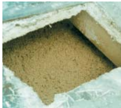
3. Otwór technologiczny do wdmuchiwania granulatu
