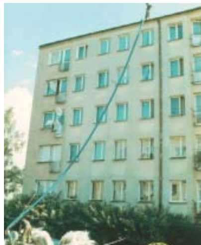
2. Ocieplenie stropodachu budynku 4-piętrowego
